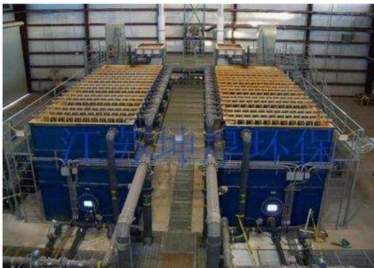
电厂废水电絮凝预处理装置组
