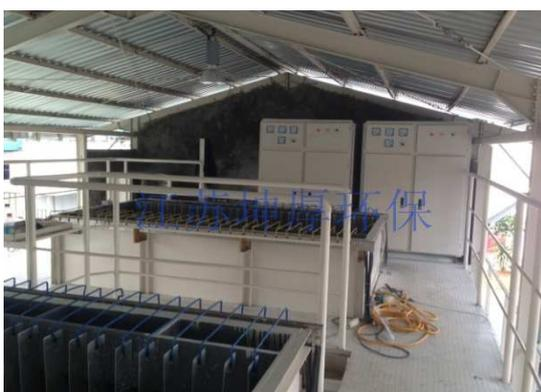
某油田回注水电絮凝处理装置组
